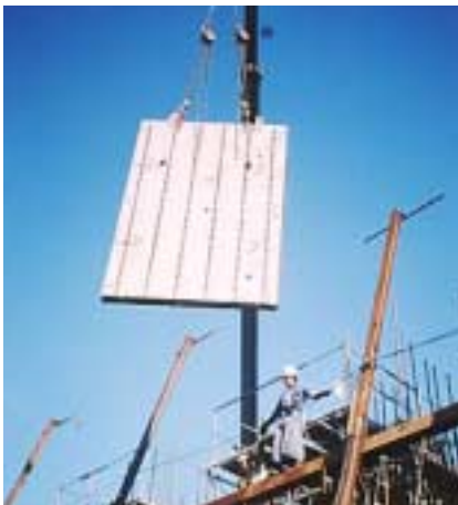
2. カイザー板吊込状況
