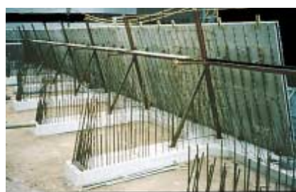
カイザー板設置完了 背面側
