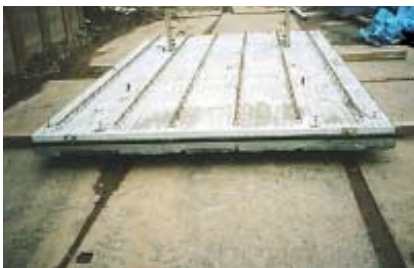
1. 石積化粧型枠カイザー板仮置
