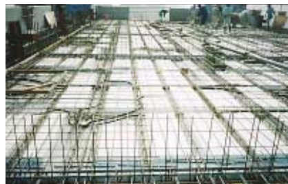
4. スラブ上端筋等の配筋
