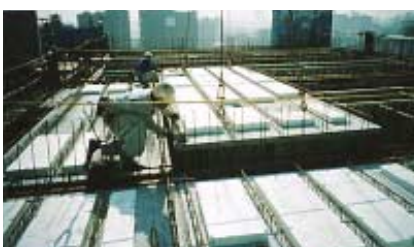
3. カイザーボイド板の敷込み
