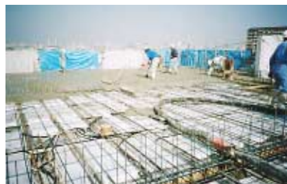
5. トッピング部コンクリートの打込み
