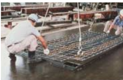
3. 先組み鉄筋のセット
