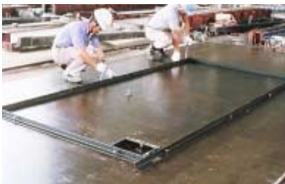
2. 周辺型枠のセット
