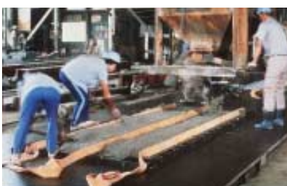
4. コンクリートの打込み
