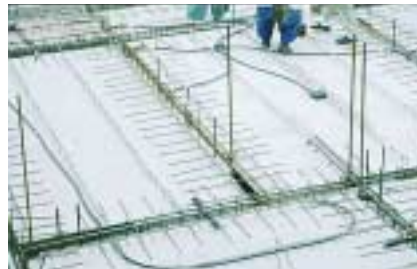
4. ジョイント筋配筋
