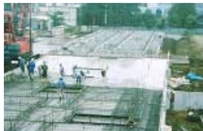
6. トップング部コンクリート打込み
