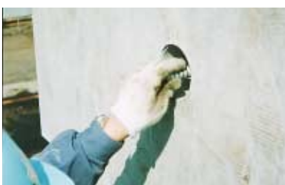
ネジ鉄筋の挿入
