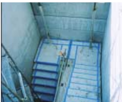
1. 取付け前状況
