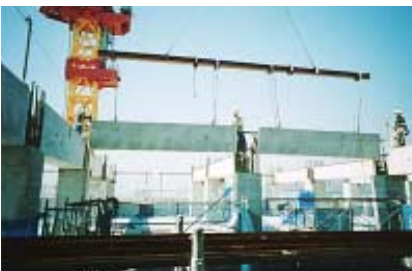
P C a 梁敷込み
