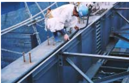
2. シール材貼付状況
