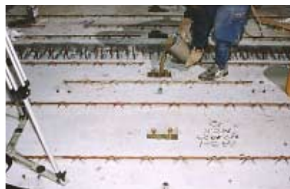
5. 無収縮モルタル充填状況
