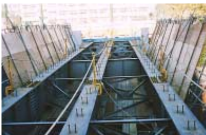
1. 鋼桁（3主桁）架設完了
