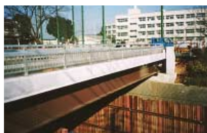
8. 高欄取付完了
