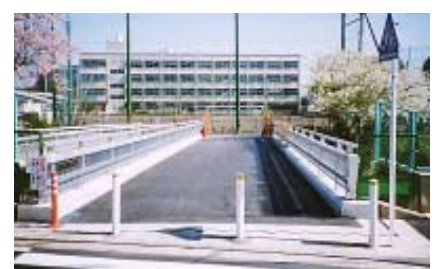
9. カイザー合成床版橋 完成全景
