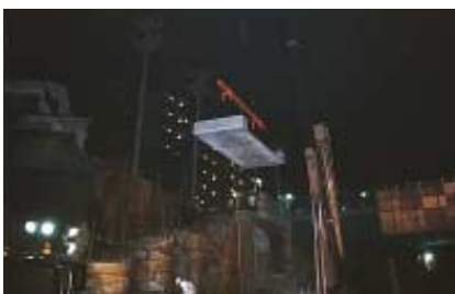
3. カイザー床版 吊込状況
