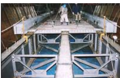
4. カイザー床版 敷設状況
