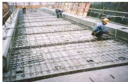
6. 上端筋組立状況
