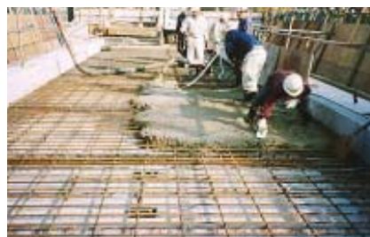
7. 床版上部 コンクリート打設状況
