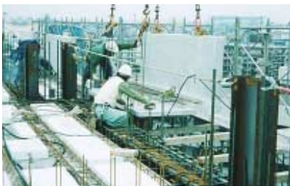
3. カイザーバルコニー板の敷込み
