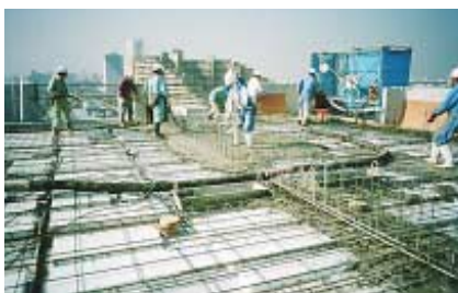
6. トッピング部のコンクリートの打込
