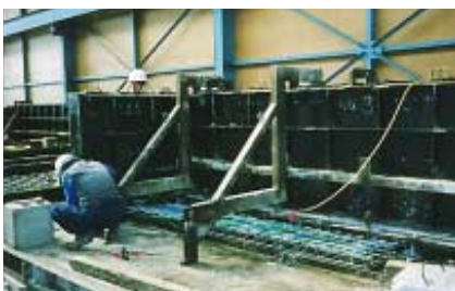
2. 製造 (コンクリート打込前)
