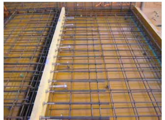
バルコニーの配筋状況
