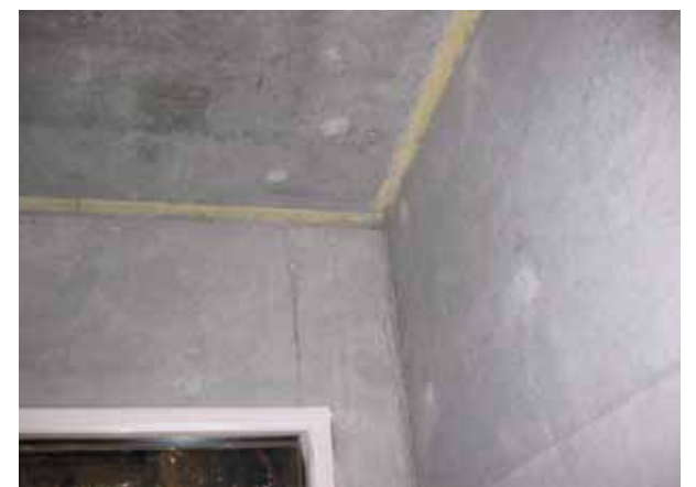
ヒートバリアの打込み完了状況（壁の断熱前）
