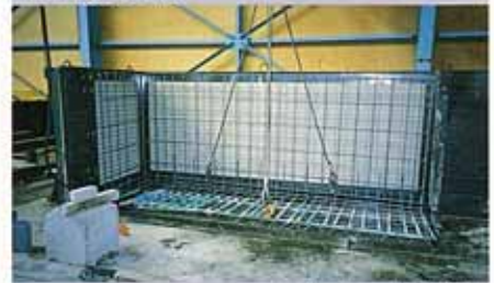
1. 型枠セット・タイル張り
