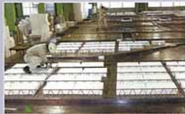
5. ボイドの取付け
