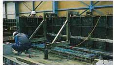
2. コンクリート打込み
