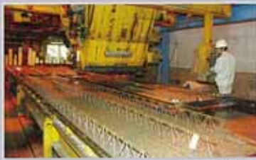
4. コンクリート打込み
