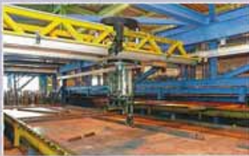
1. 周辺型枠のセット
