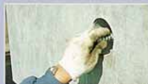
3.ネジ鉄筋の挿入
