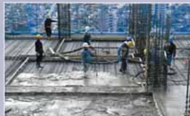
5.コンクリート打設
