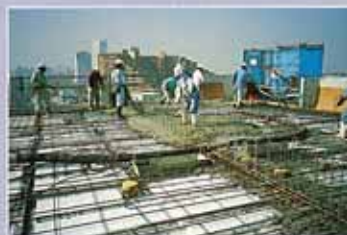
5. コンクリート打込み
