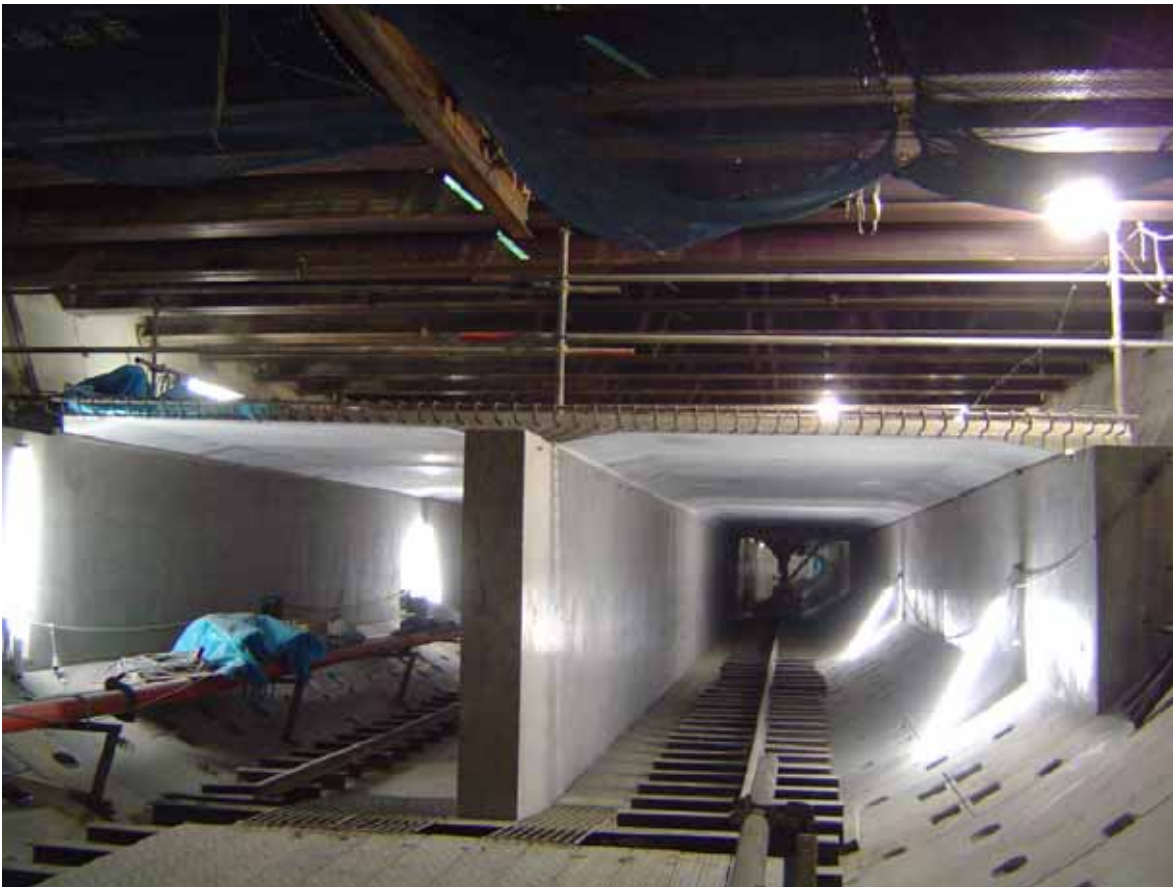
ハーフプレキャストスラブ版架設完了全景
